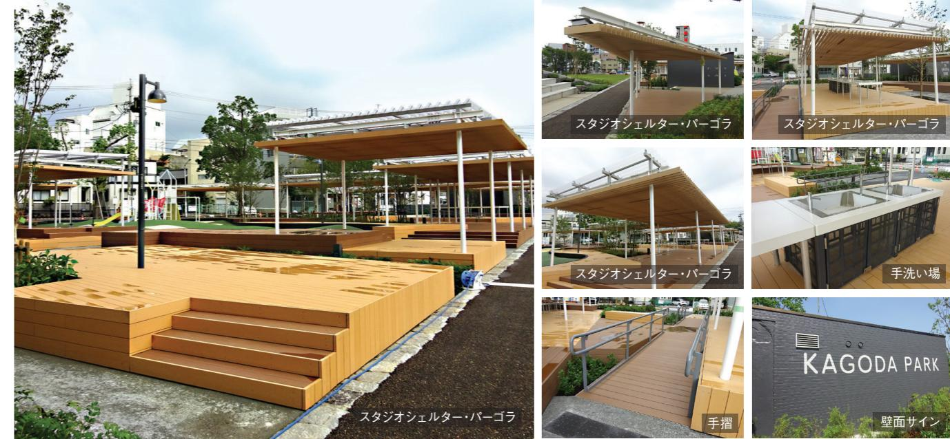
パーゴラの屋根部には、サインと同じレーザー抜きパネルを使用し空間統一を図りました。また日光の影がこのにしき模様になるようレーザー抜きの大きさや幅などを調整し、「柱を出来るだけ細くしたい」、「屋根部の面積を広げたい」などのご要望にお応えすべく検討に検討を重ねました。パーゴラ背後に自転車置き場があることから景観を損なわないよう目隠しとして腰壁パネル(これも同じにしき織デザイン)として、夜間は住棟の明かりを利用し薄っすら光るようアクリル板を使用しております。
