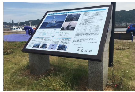
サインはモニュメントを壊さないように斜めの形のものを選び、海端ということもありサイン表示面にはSRCメタル印刷を使用し耐候性を高めました。
