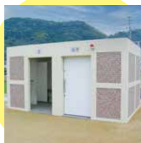
工程 10 根巻きコンクリートを打設し、埋め戻し後完成。
