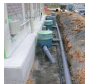
工程 9 本体から出た給排水、電気配管等を接続します。
