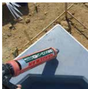
工程 6 吊り金具を外し、吊り穴はシーリングにより穴埋めし、タッチアップ塗装をします。
