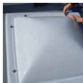
工程 7 微調整が完了したら天井のトップライトを取り付けます。
