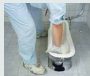
工程8の後、和便器をセットし緑周りをシーリングします。
