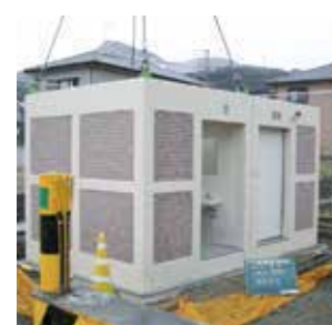
工程8 連結部へシーリングを行います。
