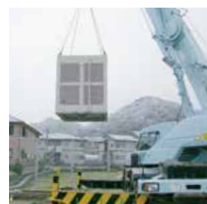
工程4 50tクレーン4点吊りにより本体を吊り上げ設置します。
