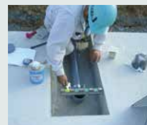
工程2の墨出し後、和便器用配管を取り付けます。
