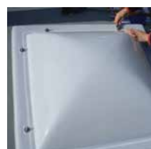
工程7 微調整が完了したら天井のトップライトを取り付けます。
