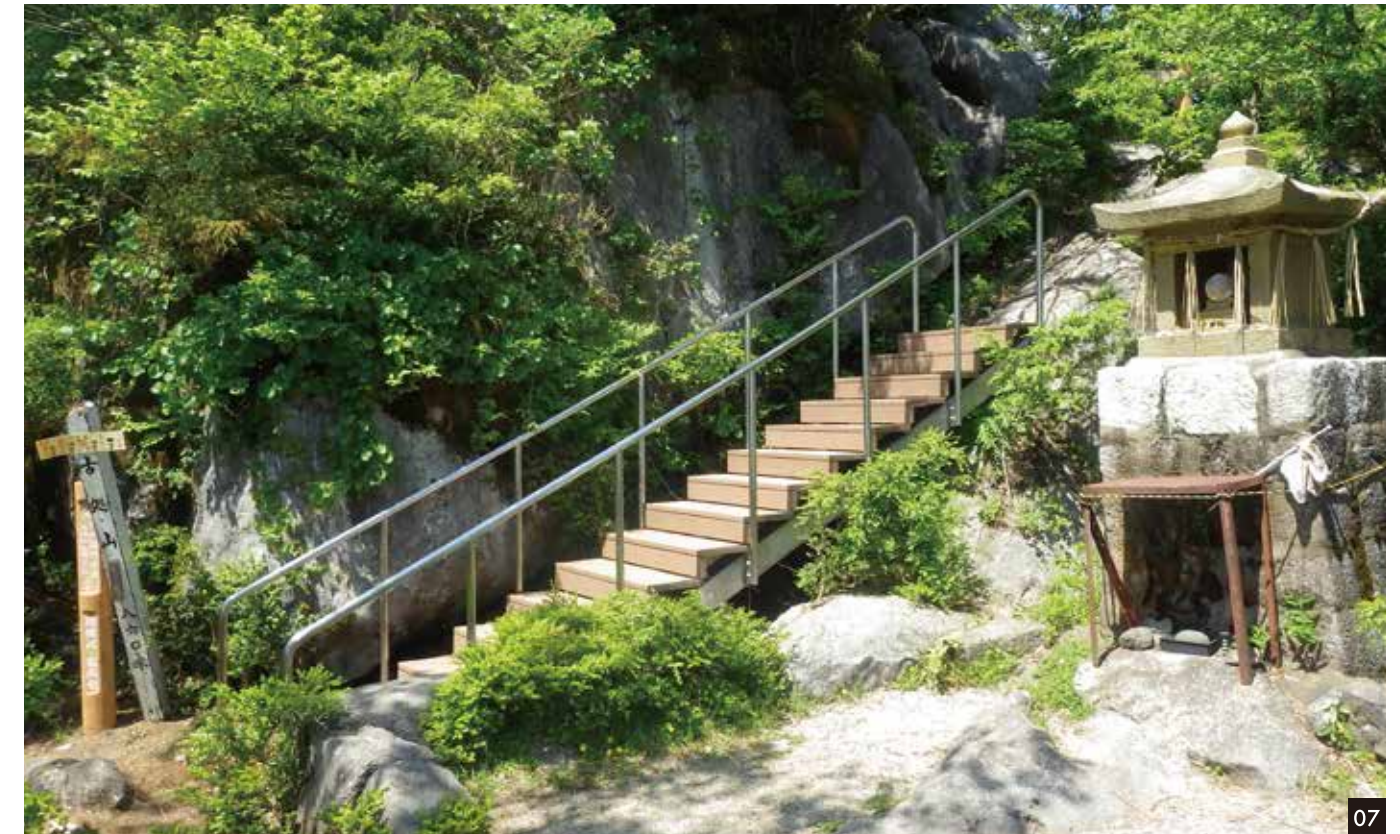
09 ST-D-3102 仕様: 再生木(床板), SGFウッド(根太)
