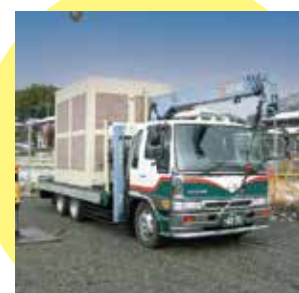
工程1 14t低床車にて現場搬入。
