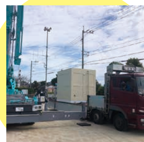
工程 1 14t低床車にて現場搬入。
