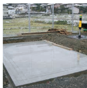
工程 2 基礎天端へ墨出しし、プレート等でレベル調整を行います。
