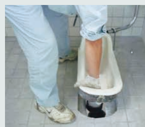
工程8の後、和便器をセットし縁周りをシーリングします。
